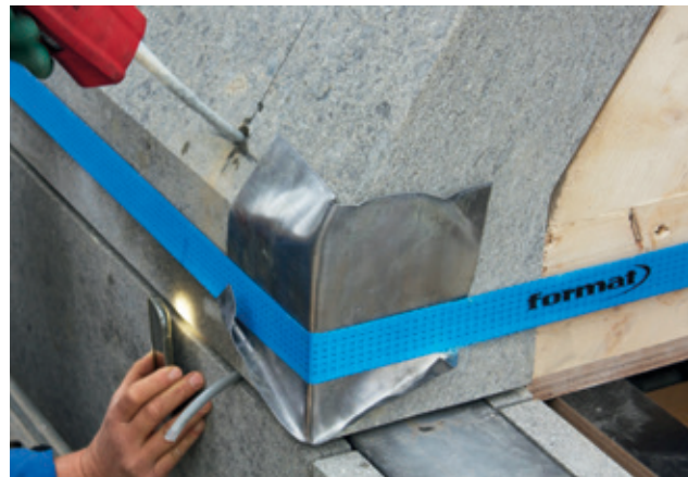
Anschließend wurde das obere Bohrloch in der Dachschräge mit Verbundmörtel verfüllt
