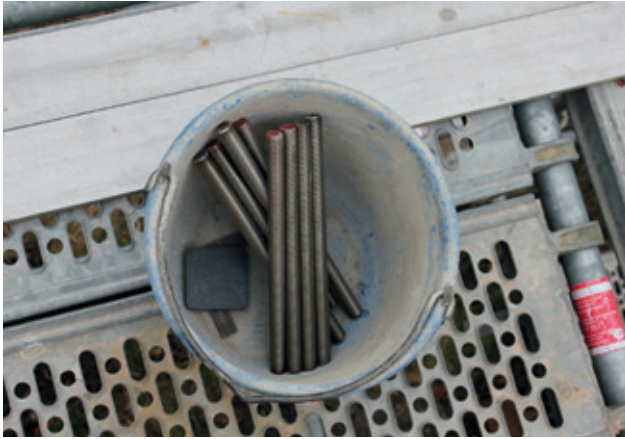
Die 36 Zentimeter langen Bolzen, Kunststoffschläuche und kleine Platten wurden vor dem Setzen platziert
