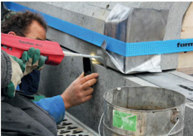
Verfüllen der Bohrlöcher: Durch einen Blick in die Fuge erkennt der Steinmetz, wann der Verbundmörtel sich tellerförmig ausbreitet
