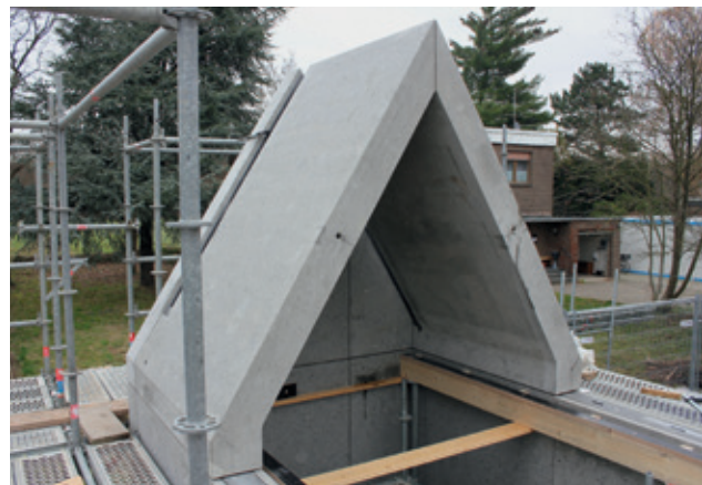
Erste Einsicht auf der Baustelle: Schon jetzt kann man den späteren Innenraum erahnen
