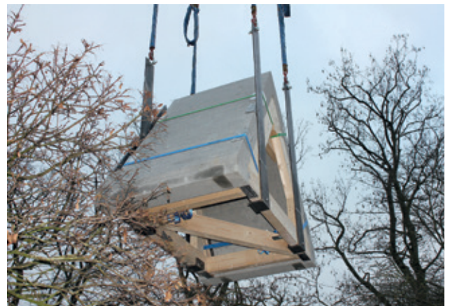
Mittels Kran werden die Dachelemente mitsamt der Holzkonstruktion einzeln an ihren Bestimmungsort geschwenkt
