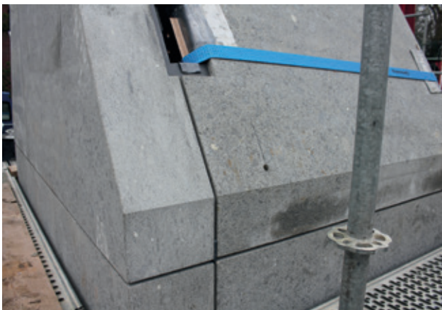
Der Fugenverlauf passt genau. Die Fugen wurden später außen mit Stopfband, Polymerkleber und Bleiwolle geschlossen
