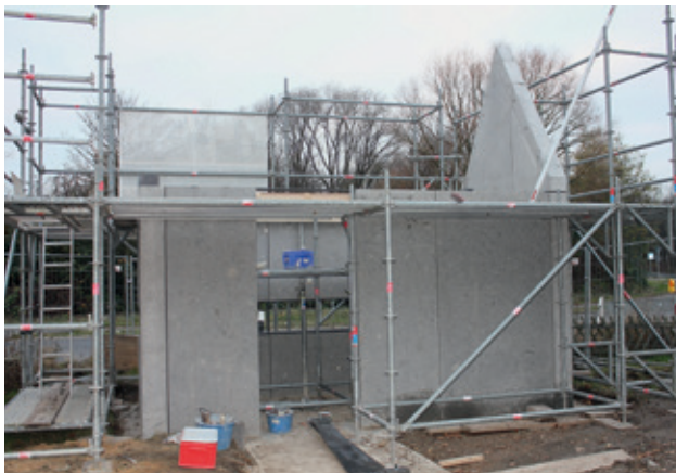
Auf der Baustelle: Wände und eine Giebelseite stehen bereits. Es fehlen noch der zweite Giebel und die drei Dachelemente
