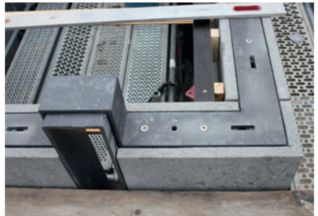
Nach dem Aufbau der Wandelemente wurde der 15 Millimeter dicke und 160 Millimeter breite Ringanker eingebaut
